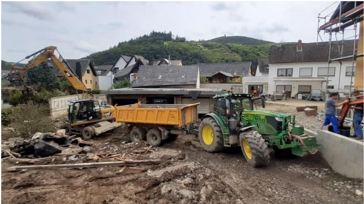
Mit Baggern Ordnung schaffen: Um der Zerstörung im Flutgebiet Herr zu werden, braucht es dringend technisches Gerät. Foto: privat
